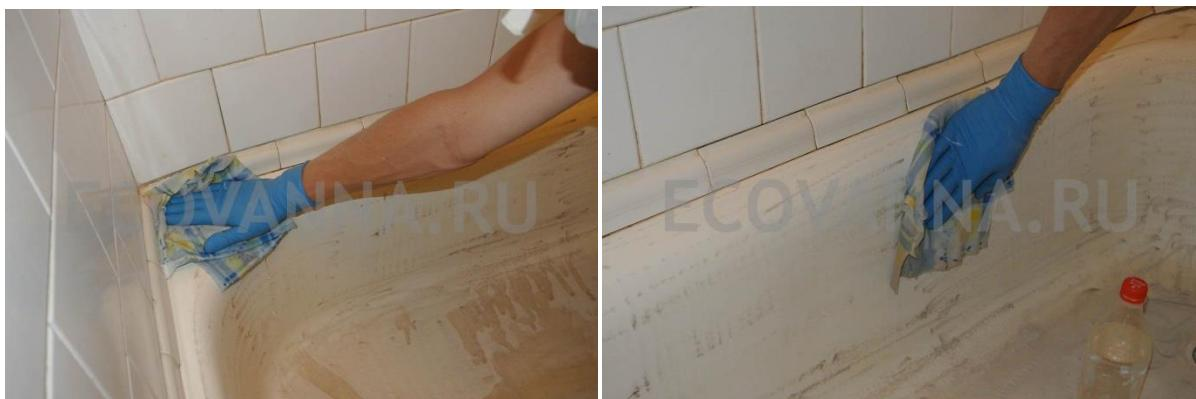
Для обезжикирования поверхности ванны используйте ацетон, нанесенный на тряпку (тряпка не должна ворситься). Повторите процедуру обезжикирования 2-3 раза подряд, разными тряпками.
