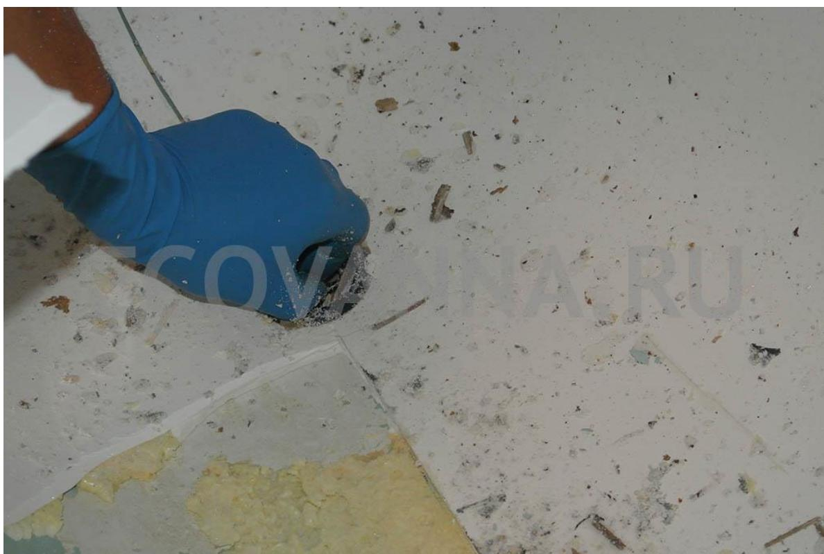
Убедившись в том, что вода под вкладышем стекла в сливное отверстие, снимаем сливное отверстие и демонтируем обвязку.
