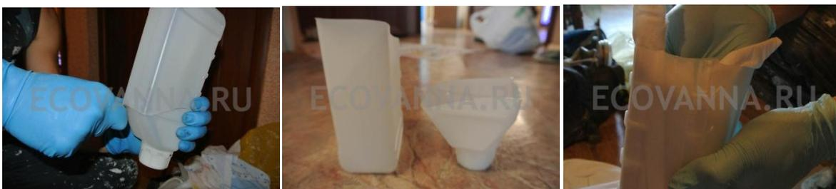
Материал наносится на ванну методом налива, удобным инструментом для налива является разрезанная бутылка от отвердителя. Обязательно протрите разрезанную бутылку сухой тряпкой, чтобы впитать весь оставшийся там отвердитель.
