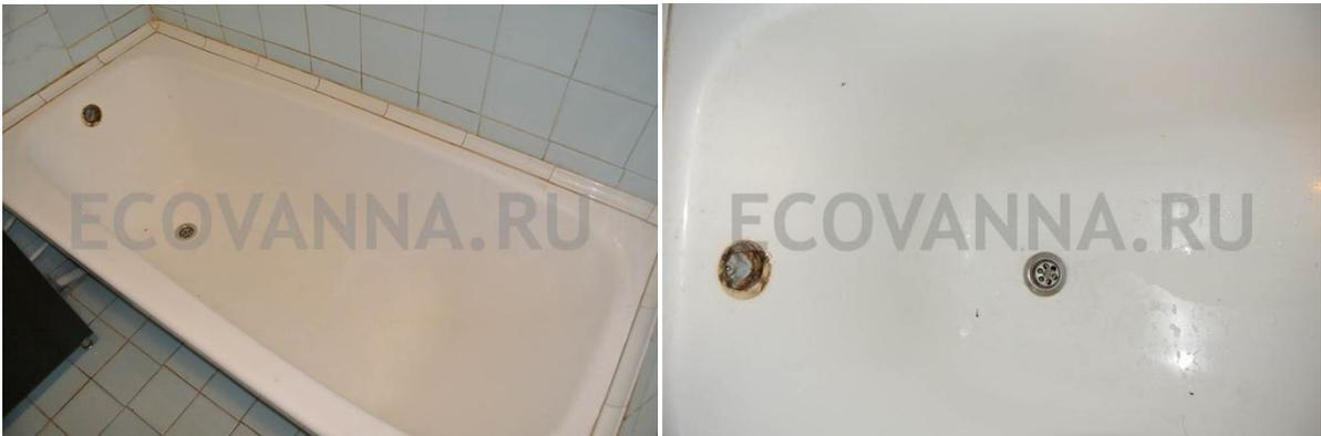
В рассматриваемом случае дно вкладыша отслоилось от ванны. Так как под вкладыш из-за отслоения могла попасть вода, сначала снимайте только переливное отверстие, оставляя сливное на месте.
