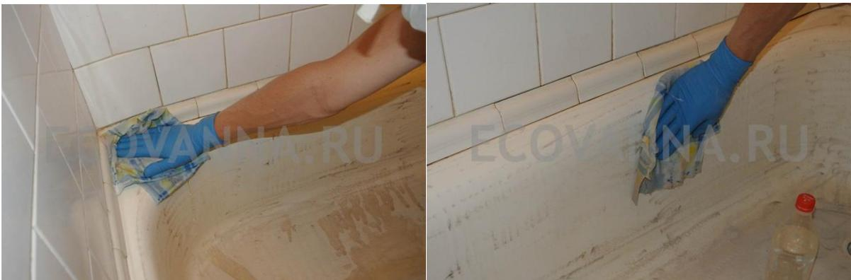
Для обезжиривания поверхности ванны используйте ацетон (Минимальный расход: 200 гр. на 1 стандартную ванну), нанесенный на тряпку (тряпка не должна ворситься). Повторите процедуру обезжиривания 3-4 раза подряд, разными тряпками. Альтернативный способ обезжиривания
