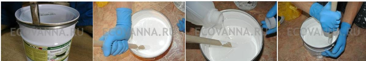
Перед смешиванием основы и отвердителя, перемешайте основу в течение 5 минут. Начините вливать отвердитель, продолжая перемешивание. После смешивания компонентов, продолжайте тщательное перемешивание в течение 10 минут. Не используйте для перемешивания дрель - это вызовет излишнее попадание воздуха в материал. После перемешивания, дайте материалу настояться в течение 10-15 минут. В это время можно заняться подготовкой инструмента для налива и т.д.
