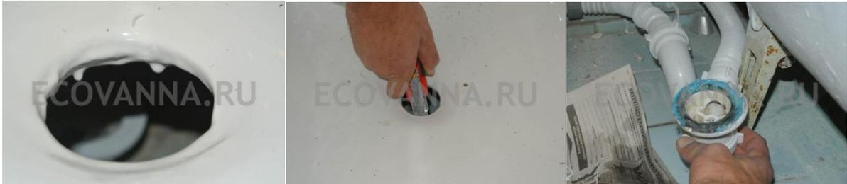
Спустя 24 часа после заливки ванны можно устанавливать обвязку. Обратите внимание на сливное отверстие - обязательно срежьте ножом застывшие капли "сосульки". Перед установкой, обработайте все соединительные части силиконом.
