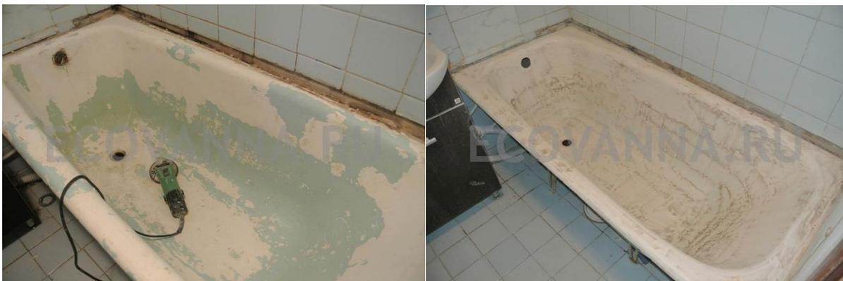
Зачистка ванны займет продолжительное время, очень тщательно обработайте ванну, используйте насадку наждачной бумаги с высокой зернистостью до полного очищения ванны. Дальнейшая процедура реставрации ничем не будет отличаться от стандартной.
