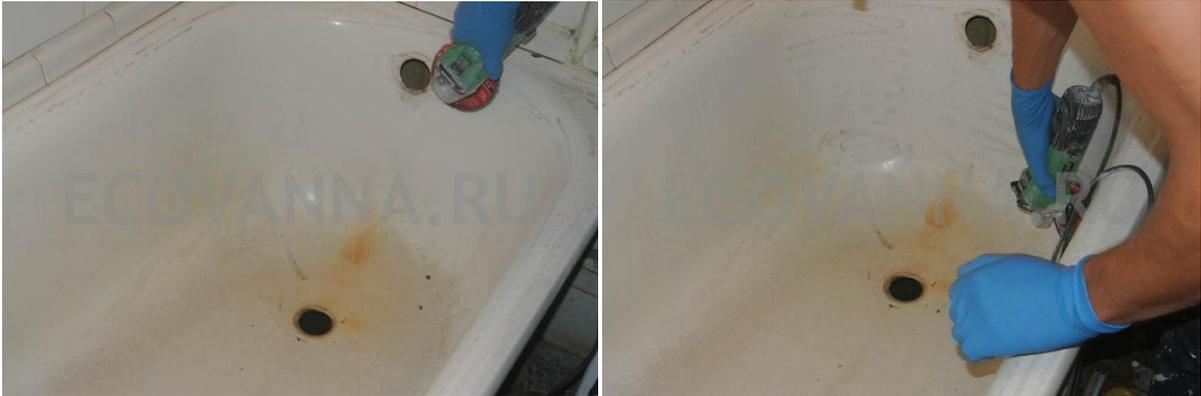
Для зачистки ванны используйте дрель или болгарку с насадкой из наждачной бумаги. В зависимости от степени загрязнения ванны можно применять насадки различной зернистости. Зачищайте ванну до полного удаления загрязнений, либо до полного удаления не заводской краски. Не забудьте надеть защитную маску.
