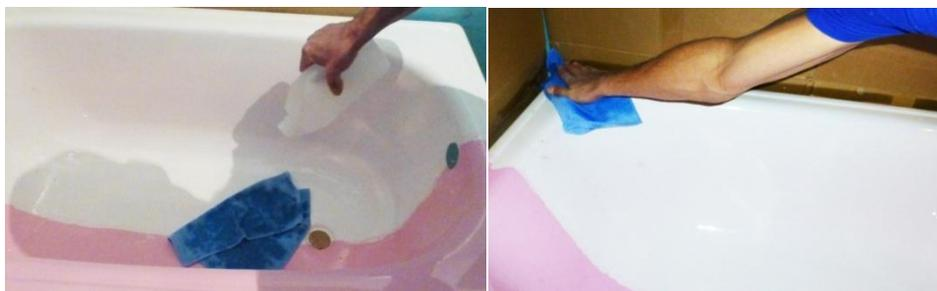
Для обезжиривания поверхности ванны используйте обезжириватель или ацетон, нанесенный на тряпку (тряпка не должна ворситься). Повторите процедуру обезжиривания 2-3 раза подряд, разными тряпками.
