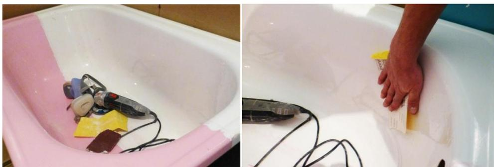
Для зачистки ванны используйте дрель или болгарку с насадкой из наждачной бумаги. В зависимости от степени загрязнения ванны можно применять насадки различной зернистости. Зачищайте ванну до полного удаления загрязнений.
